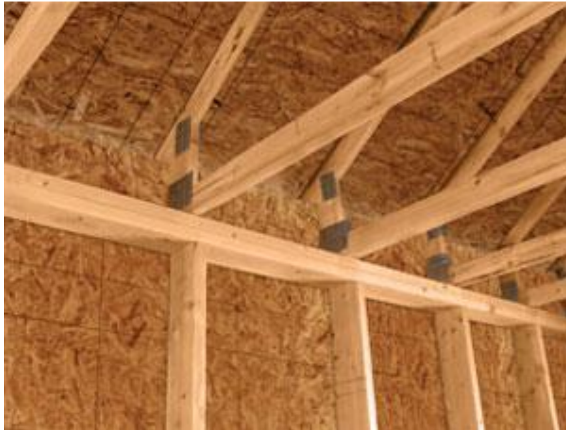
Energy Heel Truss
